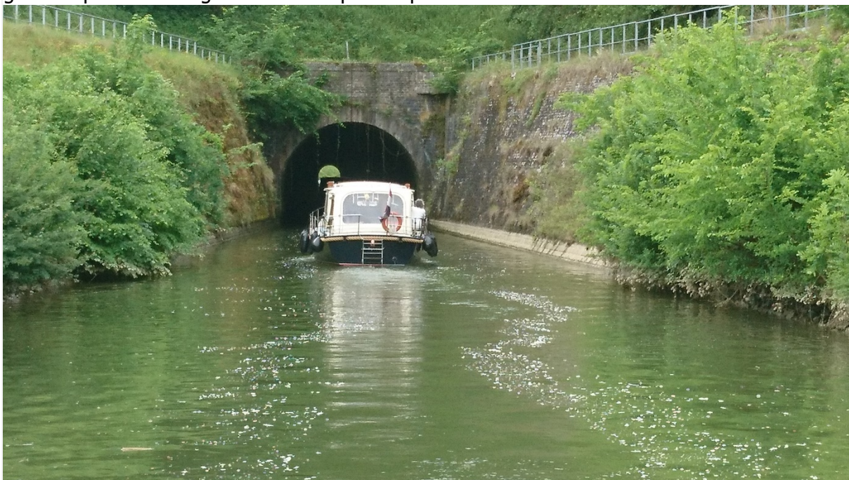
De Maritiem vaart de tunnel in.
